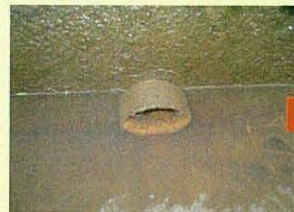
ほ場には水がたまっているのに、暗渠の排水口からは水が出ていない気配はありません…。
