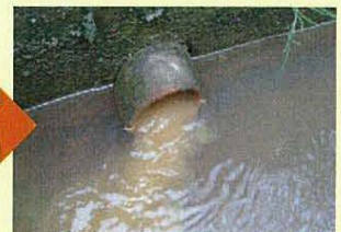
サブソイラをかけた直後、詰まっていたゴミと一緒に濁った水が勢い良く出てきました！
